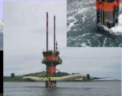
Open Hydro : "Tidal Turbine Research Structure" : Diamètre : 6 m, 250 kW
